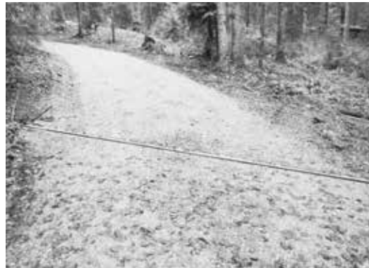
Wegunterhalt mittlerer Rotachenweg
